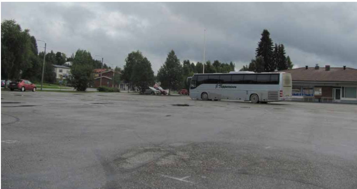
Kuva 50. Nykyisellään linja-autoaseman pysäköintijärjestelyt ovat heikosti havaittavissa.
